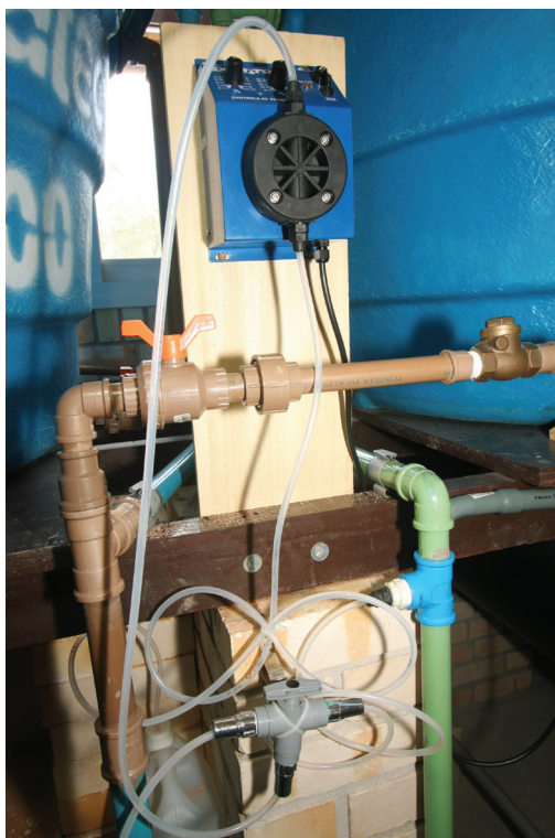
FIGURA 5.9 – Bomba dosadora.
