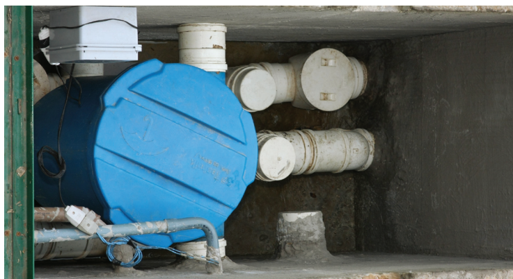
FIGURA 5.13 – Instalações que permitem avaliar a eficácia do dispositivo VF-1.
