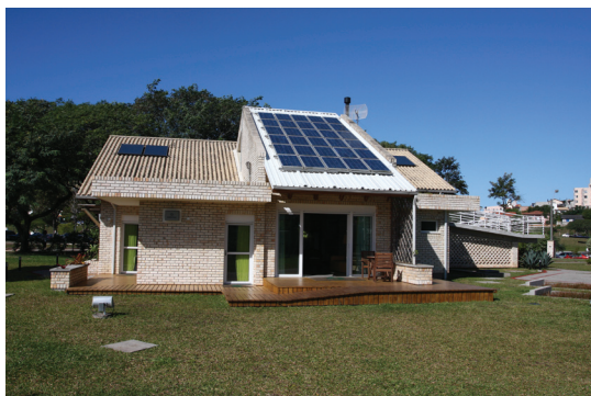
FIGURA 3 – Vista Nordeste da Casa.
