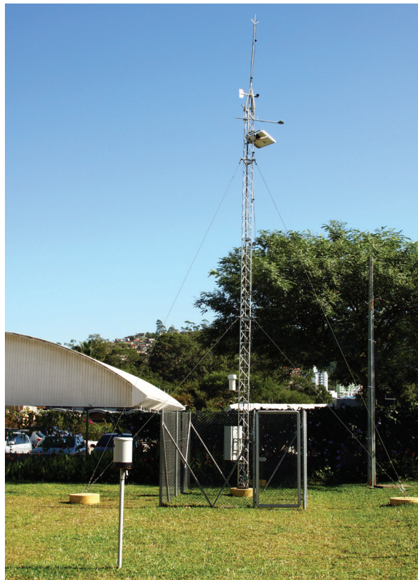
FIGURA 6.3 – Estação meteorológica instalada ao lado da Casa Eficiente.
