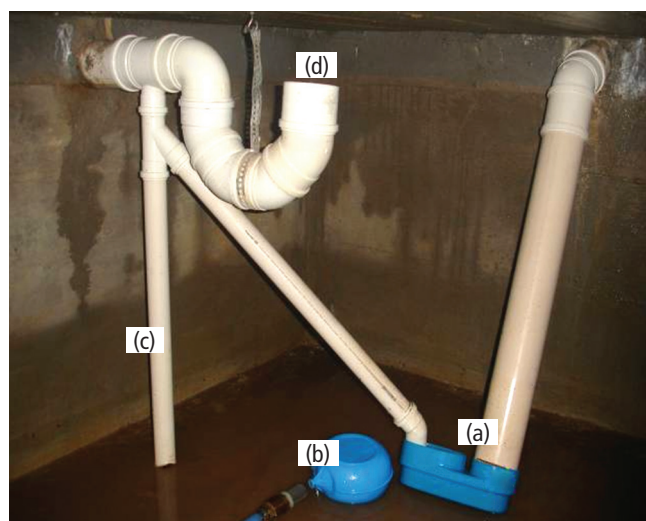
FIGURA 5.7 – Dispositivos de proteção sanitária instalados na cisterna de água de chuva - (a) Freio d'água, (b) conjunto de sucção com peneira e boia flutuante, (c) Dispositivo de retirada da água do fundo do reservatório e (d) Sifão extravasor.
