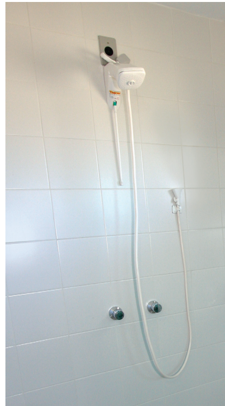
FIGURA 3.4 – Chuveiro elétrico com misturador termostático de pastilha cerâmica e arejador.
