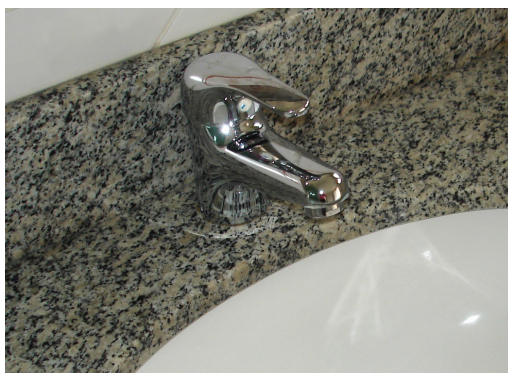
FIGURA 3.7 – Torneira do lavatório com misturador monocomando e arejador.
