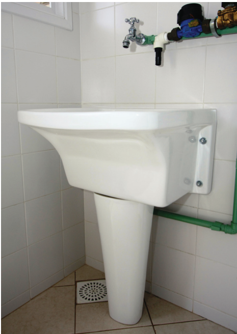
FIGURA 3.3 – Torneira de tanque com arejador.
