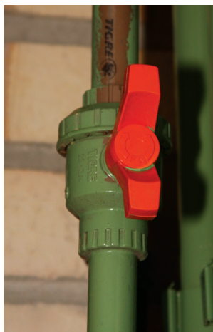
FIGURA 3.5 – Registro de esfera em PVC.
