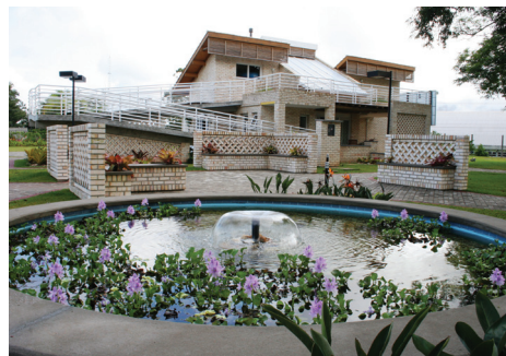
FIGURA 1 – Vista Sudoeste da Casa.
