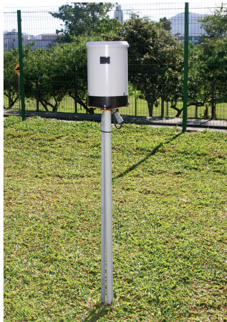
FIGURA 6.4 – Pluviômetro com sistema de aquisição e armazenamento de dados instalado junto à Casa Eficiente.
