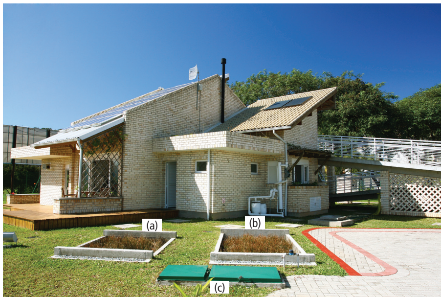
FIGURA 4.2 – (a) Tanque de zona de raízes para tratamento de águas cinzas escuras e águas negras; (b) Tanque de zona de raízes para tratamento de águas cinzas claras; (c) Cisterna para armazenamento de água de reuso.
