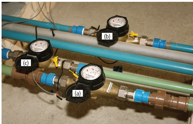
FIGURA 6.1 – Três hidrômetros monitorados pelo sistema de aquisição de dados - (a) Recalque de água pluvial, (b) Demanda de água pluvial, (c) Consumo de água potável.
