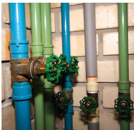
FIGURA 2.6 – Instalações prediais aparentes da Casa Eficiente com indicação de cores distintas.
