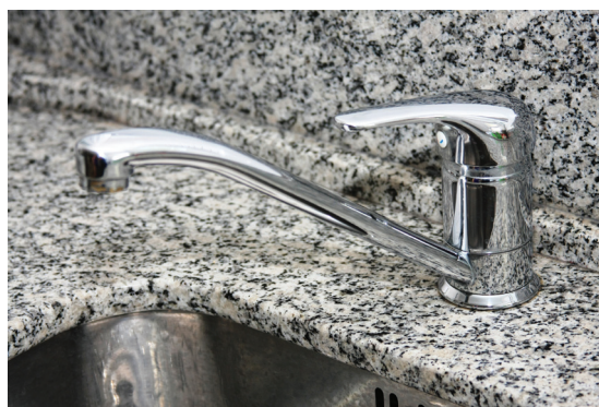
FIGURA 3.8 – Torneira de pia da cozinha com misturador monocomando e arejador.
