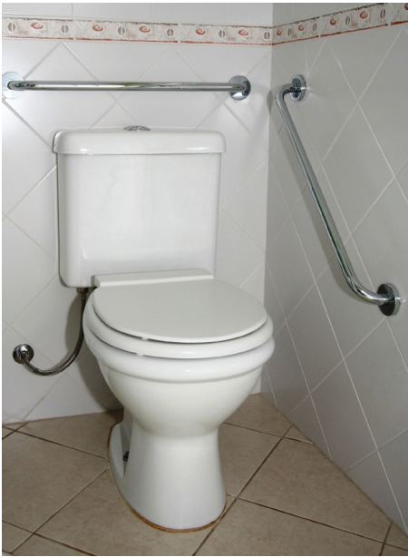
FIGURA 3.1 – Vaso sanitário com caixa acoplada, válvula de descarga com dispositivo de acionamento seletivo e regulador de vazão.
