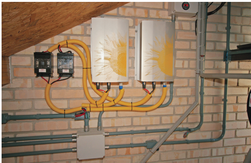
FIGURA 4.7 – Inversores e chaves seccionadoras do sistema fotovoltaico.
