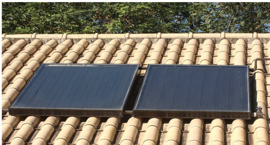
FIGURA 3.8 – Detalhe das placas coletoras sobre o telhado da Casa Eficiente.
