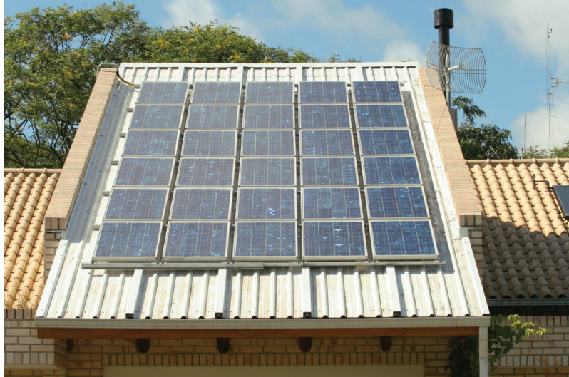
FIGURA 4.4 – Painel fotovoltaico do sistema, composto de 30 módulos de silício policristalino (p-Si).
