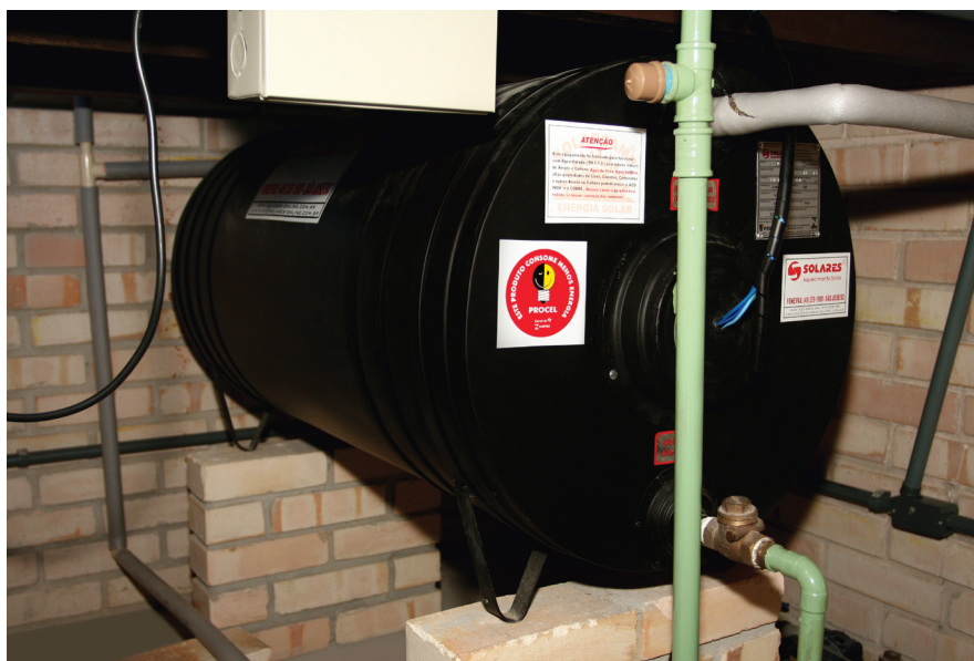
FIGURA 3.9 – Reservatório térmico usado na Casa Eficiente.
