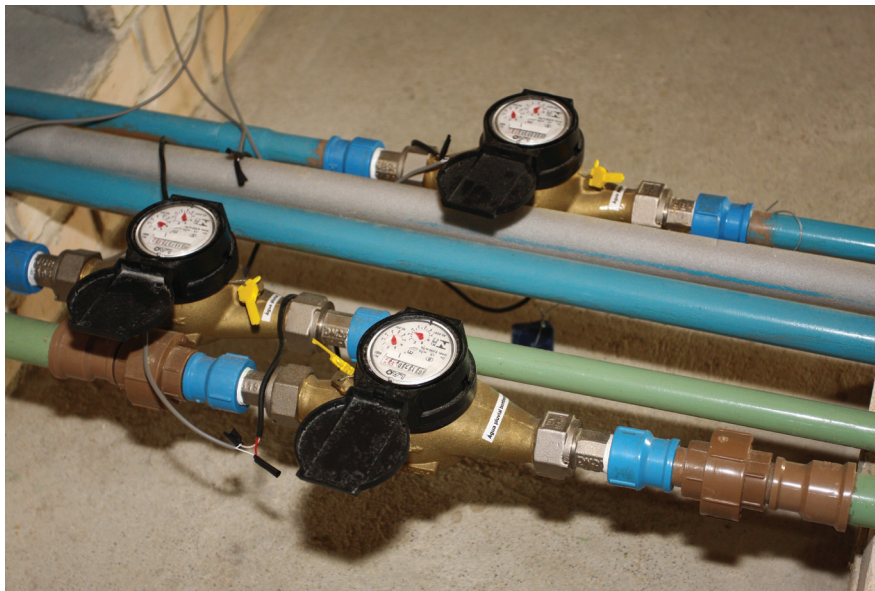
FIGURA 3.13 – Hidrômetros de medição de volume total de água consumido.
