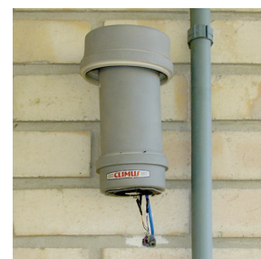
FIGURA 2.8 – Sensores de monitoramento ambiental na parede da varanda Sul.
