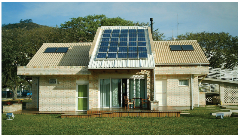
FIGURA 4.3 – Vista da fachada Norte da Casa Eficiente com o painel fotovoltaico integrado na parte central da cobertura.
